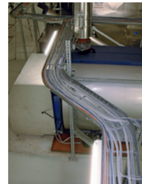
Le canaline aperte offrono un'interessante alternativa alle soluzioni tradizionali
