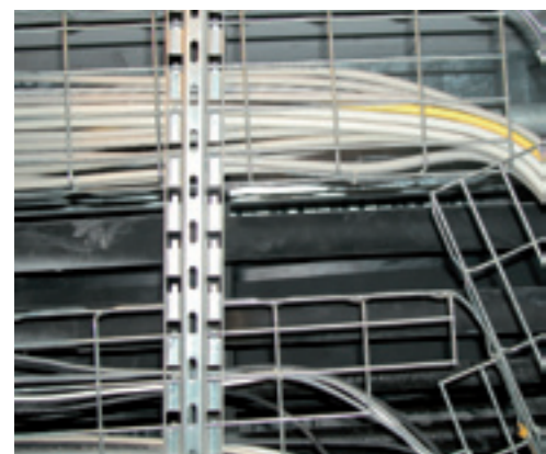
Un elevato numero di cavi può sradicare i tasselli di ancoraggio
