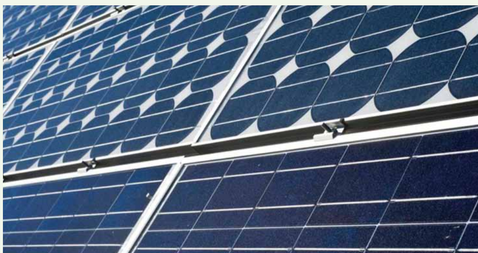
Impianti a microinverter: se presenti moduli diversi (mismatching), ognuno lavora al massimo
