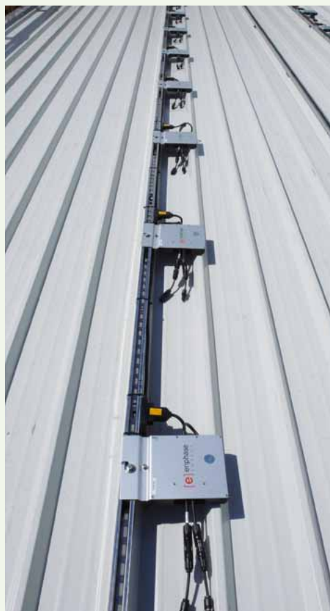
Il microinverter si monta sotto il modulo fotovoltaico, fissandolo alla stessa struttura che supporta il modulo.
