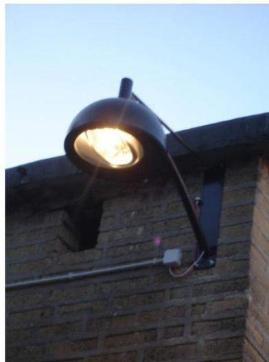
**Figura 6.24- sbraccio a muro con armatura cut off**
