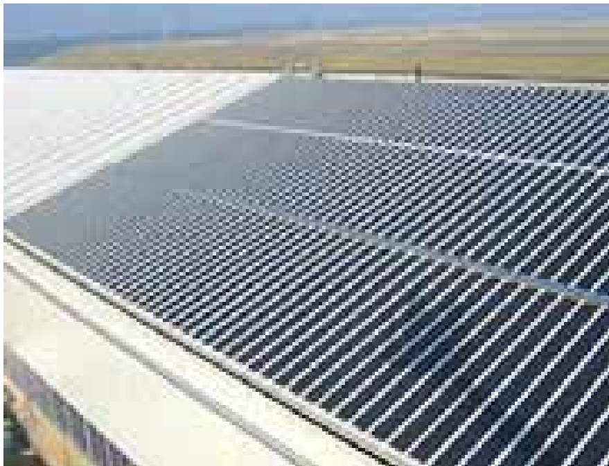
Ubicazione / Site Ravenna (RA) Potenza / Capacity 194 kW p
